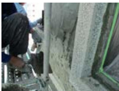
外牆打底施作
