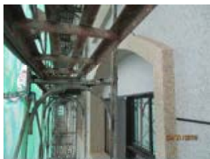
外牆塗料施工完成
