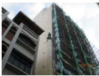
建築物側面防水漆刷塗
