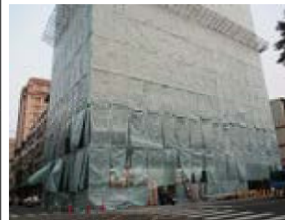
鷹架與防塵網完成
