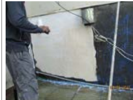
屋頂女兒牆防水更新處理
