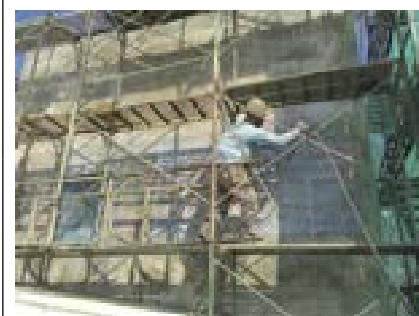
滲透型底漆作業噴塗
