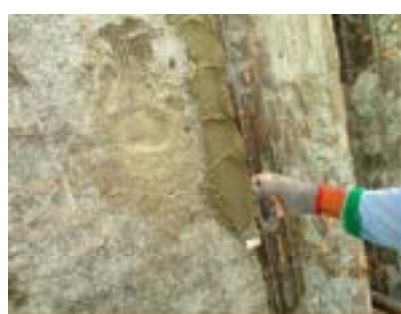
外牆表面修補
