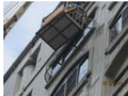
突出外牆鐵窗拆除
