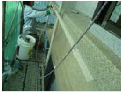
外牆滴水壓條施作
