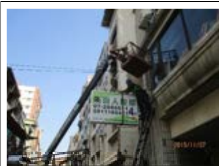
外牆招牌拆除
