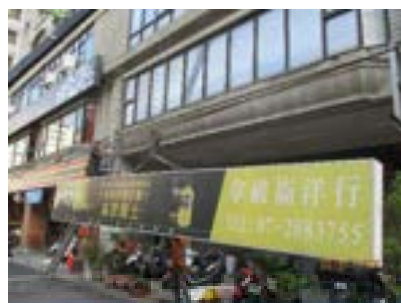
外牆招牌拆除
