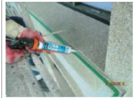
外牆滴水壓條施作
